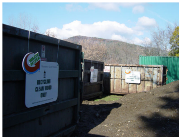
شکل ۵- مشخص نمودن ظروف مخصوص ضایعات ساختمانی با علامتگذاری در کارگاه
